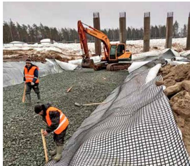
армируют металлической сеткой, засыпают щебнем, укрепляют матрацами Рено. Если на Обходе Аксая использовались матрацы тюфячного типа на насыпь, то на нулевом этапе М-12 габионы представляют собой высокую вертикальную стену и горизонтальную армонасыпь с ответвлениями, засыпанными песком. Как мы уже рассказывали ранее, геотекстиль здесь склеен с пластиковой георешеткой, а помимо пластиковой георешетки использована еще и стальная жила. И эти объекты «УДМС» возводила практически одновременно.
